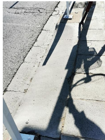
Ράμπα διάβασης πεζών πλησίον της στάσης με αρ. 353 «Λεωφ. Ιωσήφ Χατζηιωσήφ - Λυκείου Αποστ. Βαρνάβα 2»
